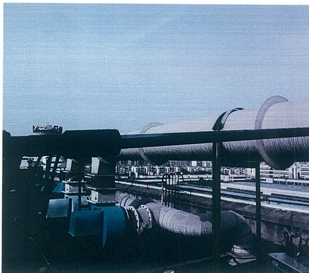
PCVD 废气排口◎7#有组织废气检测点位
